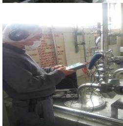
Se colocaron medidores de flujo ultrasónico TDS100H dentro de las áreas de llenado, jarabes y tratamiento de aguas de proceso (TAP) para registrar la cantidad de nitrógeno y bióxido de carbono se consume en las distintas áreas.
