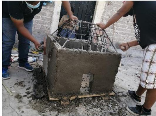
Fig. 6. En la figura se aprecia el desmontaje de la simbra que se colocó para el recubrimiento de concreto, para obtener una mejor estética. Fuente: Fotografía tomada por el equipo de trabajo.
