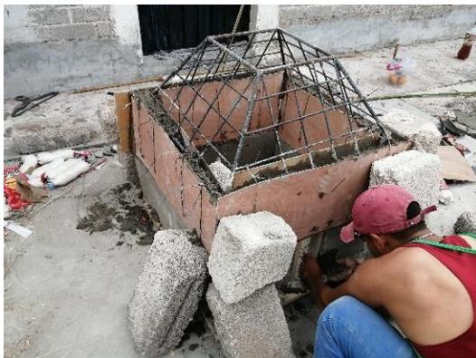
Fig. 5. Realizada la colocación de todas las botellas PET y una vez sujeta se procede a la recubrirla por medio de concreto. Fuente: Fotografía tomada por el equipo de trabajo.
