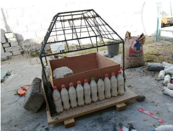
Fig. 4. Se sujetan las botellas PET a la estructura metálica, colocando un molde de madera para que sirva como moldura al momento de verter el concreto para su recubrimiento y mejor firmeza. Fuente: Fotografía tomada por el equipo de trabajo.
