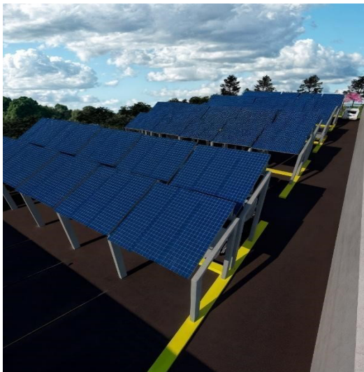
Figura 7. Disposición de los 120 paneles en la zona vehicular.
