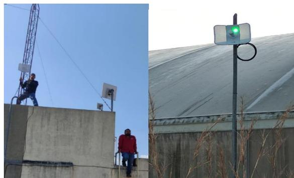
Figura 7. Infraestructura de comunicación inalámbrica entre el servidor local y los invernaderos mediante antenas CPE710.
